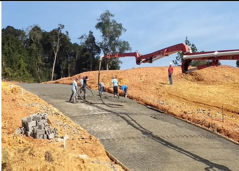
Foto 4 – Concretagem em execução
