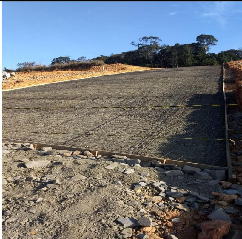
Foto 2 – montagem da armadura
