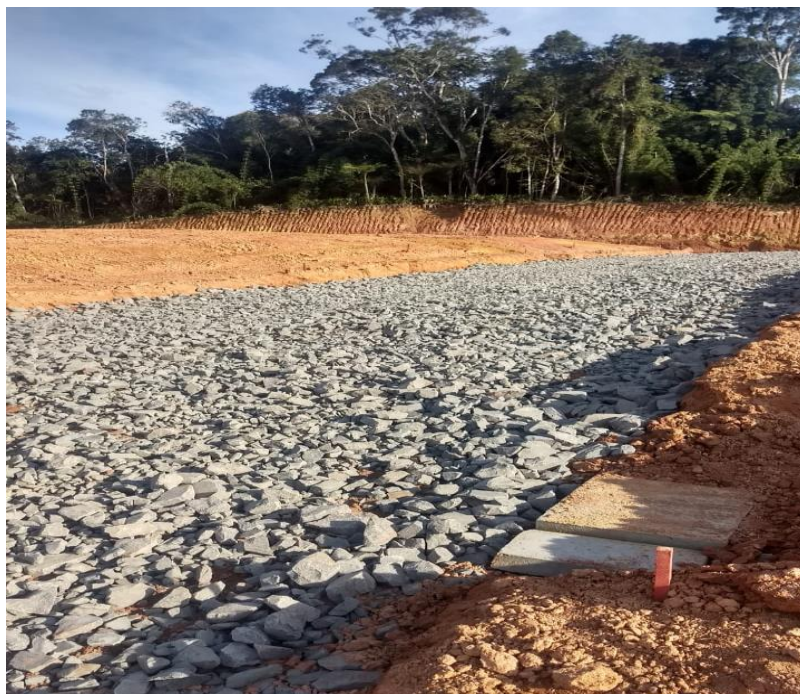
Foto 1 – camada de dreno
