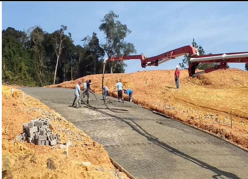
Foto 4 – Concretagem em execução
