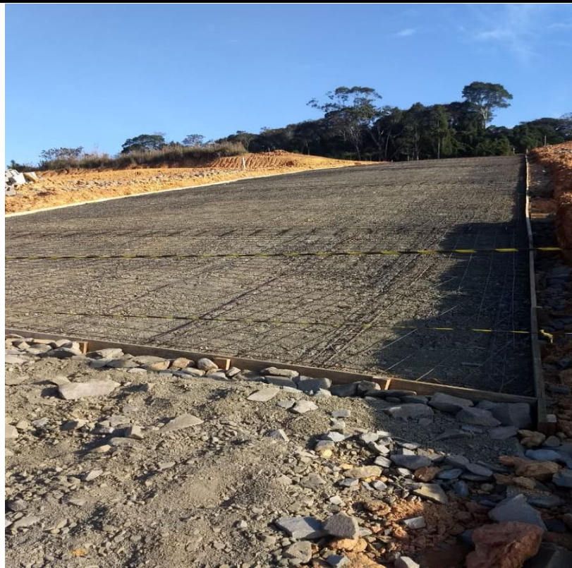
Foto 2 – montagem da armadura
