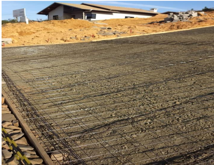
Foto 3 – pronto para concretagem
