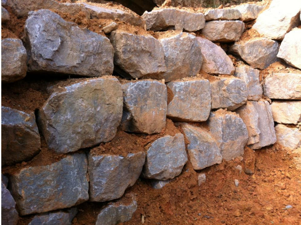
Figura 03 – Imagem ilustrativa quanto à dimensão e o formato peculiar da pedra mataco.
