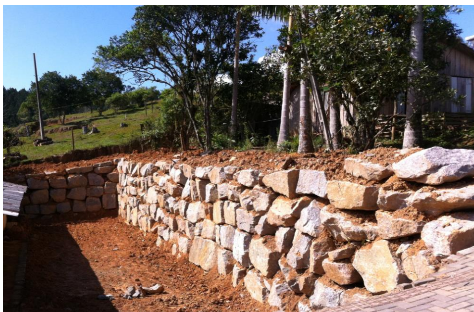
Figura 01 – Imagem ilustrativa quanto à uma construção de cortina de pedra mataco executada em Witmarsum, SC.
