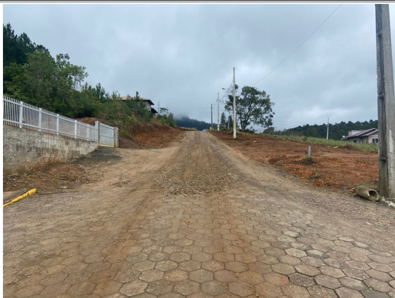
Figura 4– Rua Lídiaa Paduin – OOP / Início do trecho a ser pavimentado
