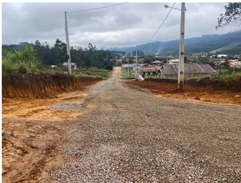
Figura 3– Rua Marcolina Paduin – est 13 + 8,00 m / Fim do trecho a ser pavimentado
