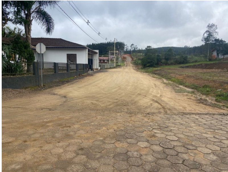
Figura 2– Rua Marcolina Paduin – OOP / Início do trecho a ser pavimentado
