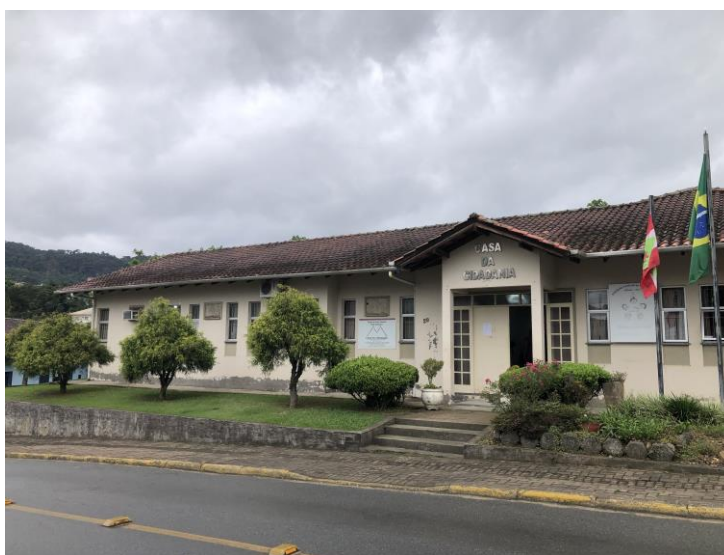
Imagem 1 – Fachada da edificação
