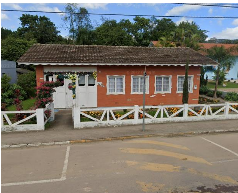
Imagem 1 – Fachada da edificação
