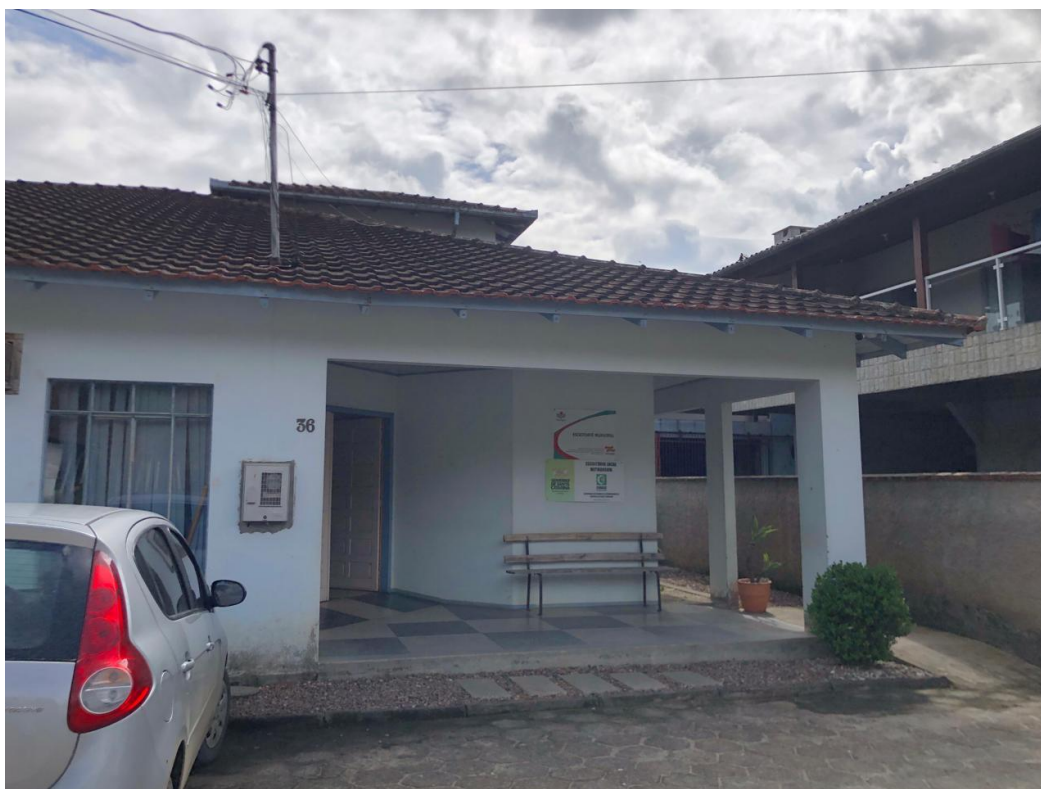
Imagem 1 – Fachada da edificação
